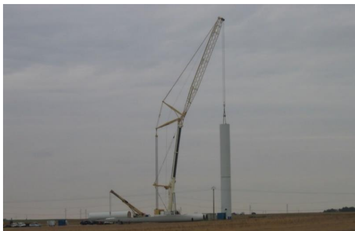
Figure 138 : Plateforme en phase chantier
